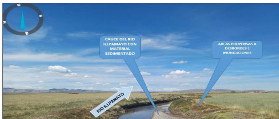
FIGURA 1 y 2 : TRAMO CRÍTICO EN EL RÍO ILLPAMAYO, EN EL SECTOR PIAS HUAYTA, DISTRITO DE LAMPA, PROVINCIA DE LAMPA - PUNO. NOTESE, LA ACUMULACION DE MATERIAL SEDIMENTADO EN EL CAUCE, QUE REQUIERE SER ELIMINADO PARA REESTABLECER LA SECCION HIDRAULICA DE LA CAJA DEL CAUCE EN ESTE SECTOR.
